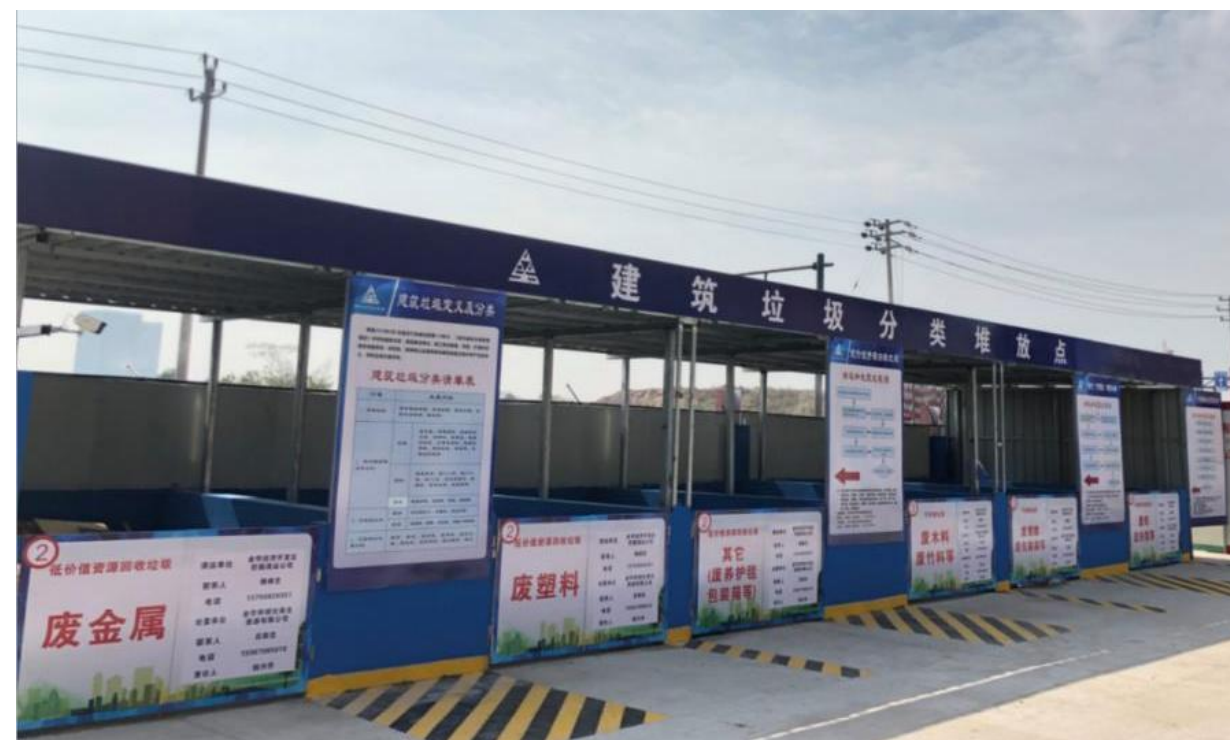
图 4-7 建筑工地建筑垃圾分类存放点示例
